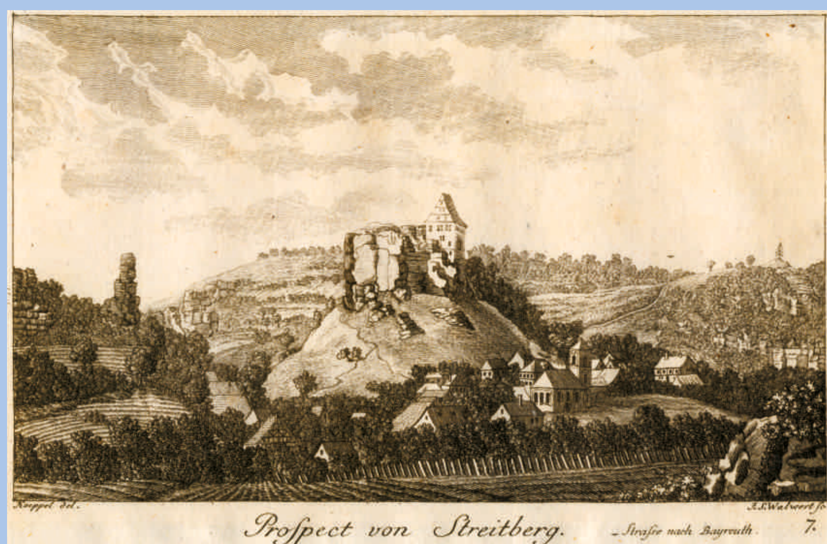
Streitberger Burg in einer Ansicht von Süden (Kupferstich von J.S. Walwert, 1787)
